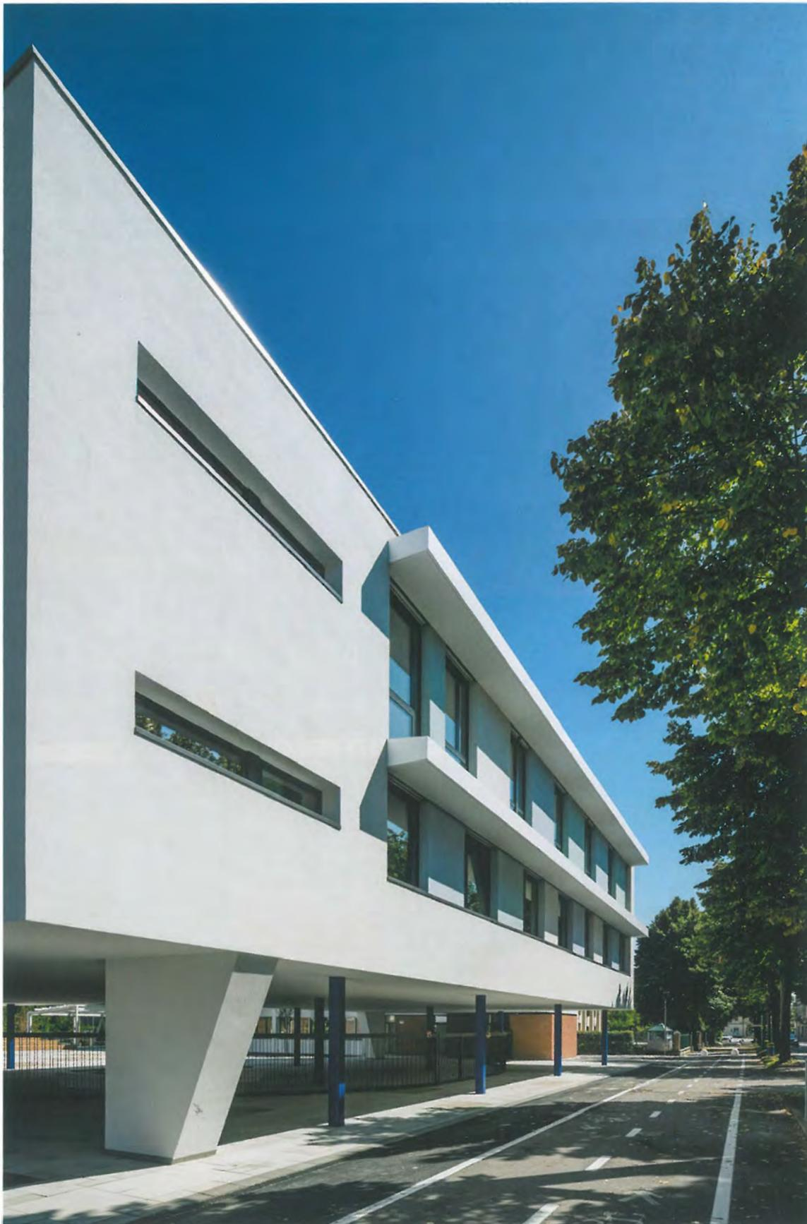
piccoli fruitori la loro collocazione nello spazio, attraverso una »panca-foro« circolare. Questa è resa possibile anche dalla particolare tecnologia costruttiva della scuola, realizzata con pilastri cavi metallici, che sostengono solai monolitici in cemento armato ad armatura incrociata.
